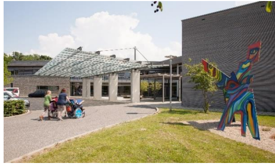
Abb. 23: Außenansicht der Martinsschule Ladenburg © RNK
