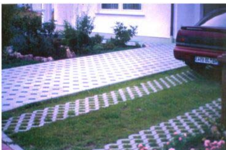
Abb. 20-2: Beispiel für privaten Stellplatz Garagenzufahrt mit befestigter Fahrspur (Rasengittersteine) und Rasen
